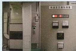
室温・測定機・測定部品が常に常温(20°C±1°C)であるよう徹底管理
